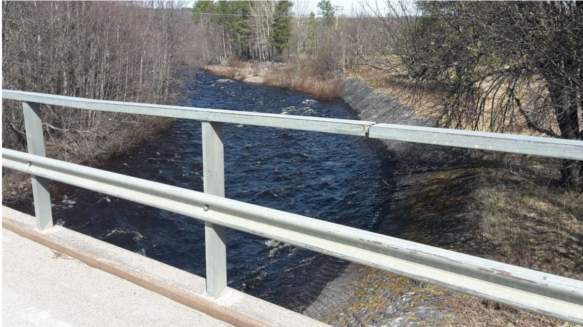
Figur 5 Norr-Veman. Vy uppströms från Håbron, 11 maj 2016. Vattenföringen är ca 17 m 3 /s (SMHI).
